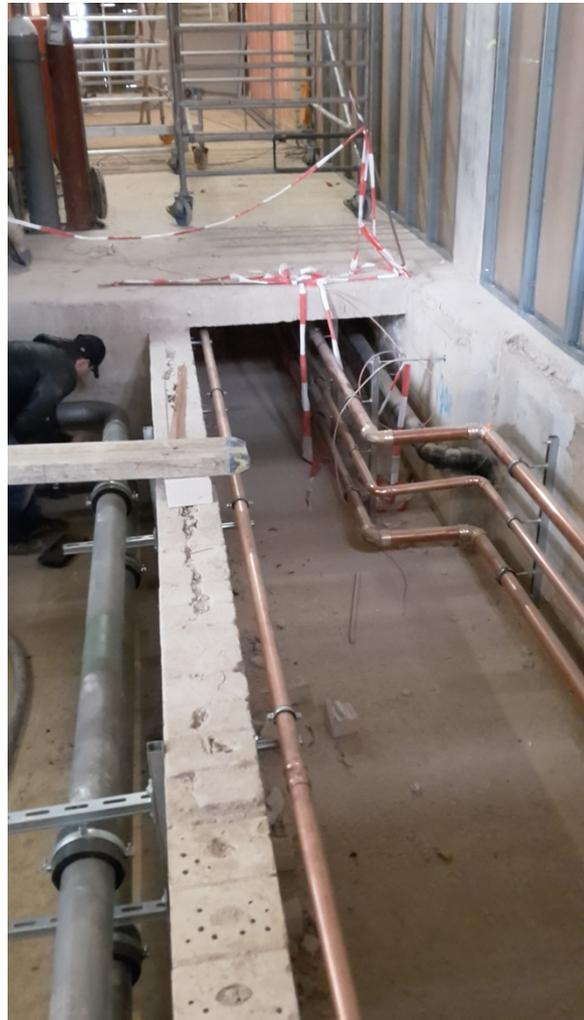
Bild 4 – Sanitärinstallation im Versorgungskanal
